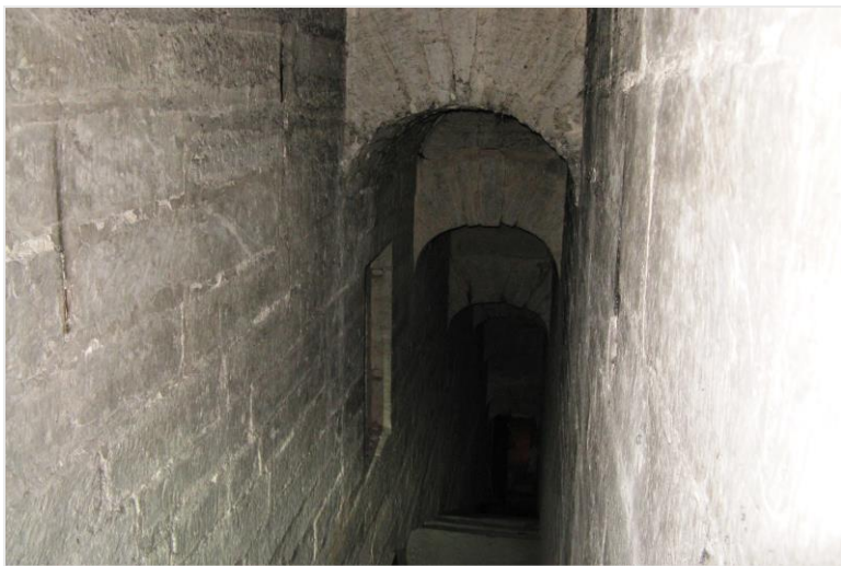
Фото 5. Внутрестеновая лестница на второй этаж алтарной части Троицкого собора со слуховым окном
